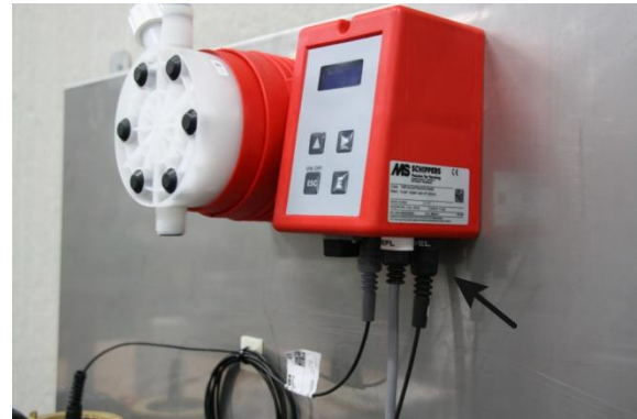
Abbildung 2: Anschließen von Trockenlaufschutz
