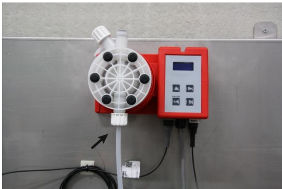
Abbildung 3: Saugschlauch anschließen
